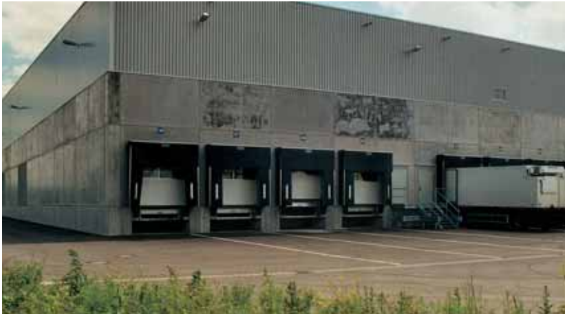
Etat général du béton avant lasurage
