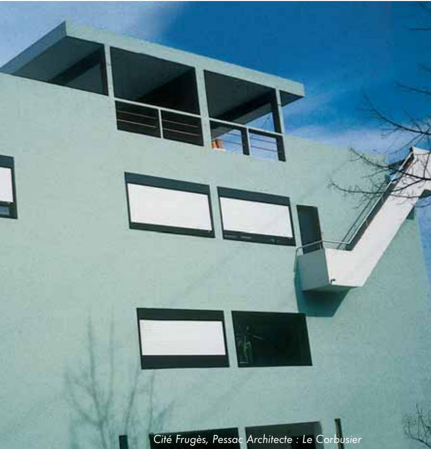
Lasure opaque sur béton préfabriqué
