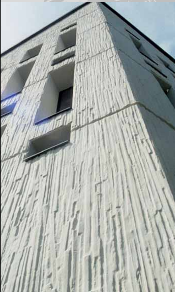
Lasures semi-transparentes sur bétons matricés
