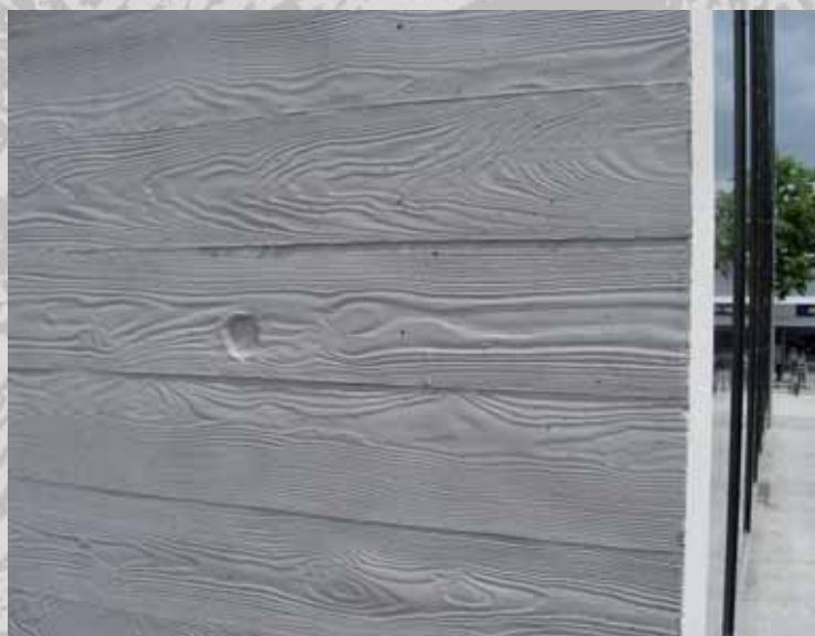
Lasures semi-transparentes sur bétons matricés
