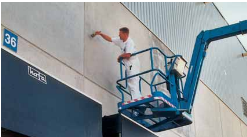
Application de la lasure CONCRETAL
