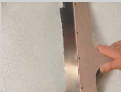
3 Dressage de l'enduit
